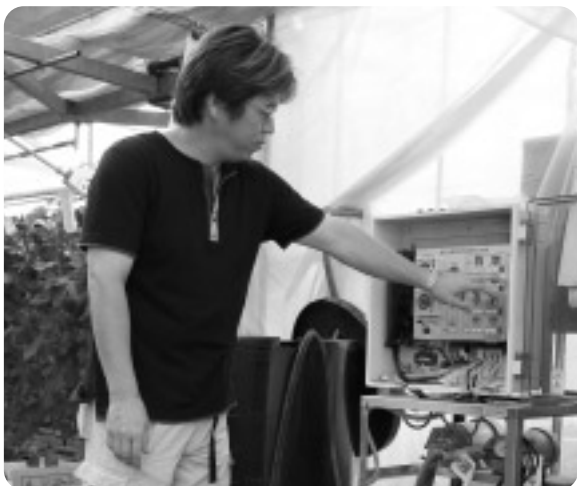
ハウスのキュウリ施肥管理は、すべて「養液土耕・液肥混入装置」で調整
